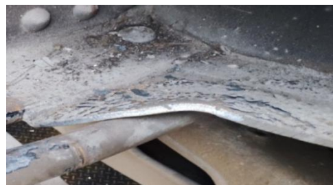
Рис. 8. Пошкодження підсилювальної косинки шворневого вузла
