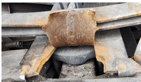
Рис. 5. Пошкодження верхньої полки хребтової балки
