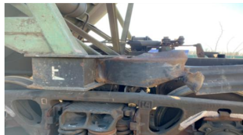
Рис. 10. Пошкодження обшивки рами
