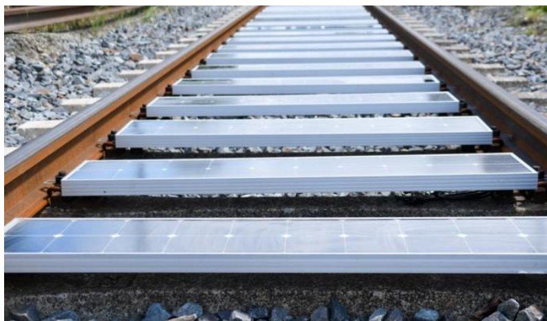
Рис. 2. Сонячні панелі, встановлені на шпалах німецької залізниці
