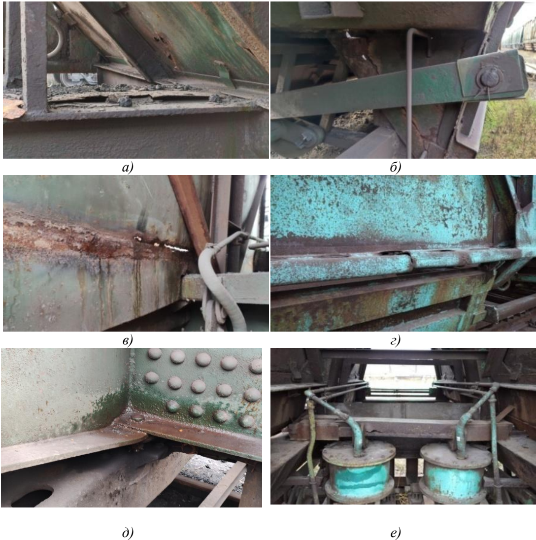
Рис. 2. Механічні та корозійні пошкодження вагонів-хоперів для перевезення охолодженого коксу
