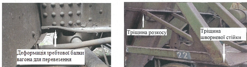
Рис. 4. Деформації та тріщини елементів конструкції зерновозів
