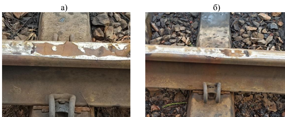
Рис. 5. Технічний стан рейок (а) – вибоїни на головці; б) – розширення головки та вибоїни
