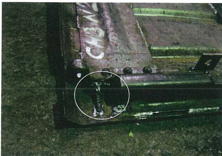
Рис. 14. Испытуемый образец № 2 – после проведения ремонта
