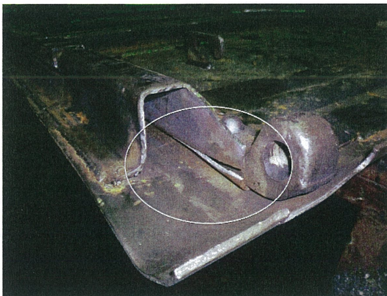
Рис. 11. Испытуемый образец № 1 – перед проведением ремонта
