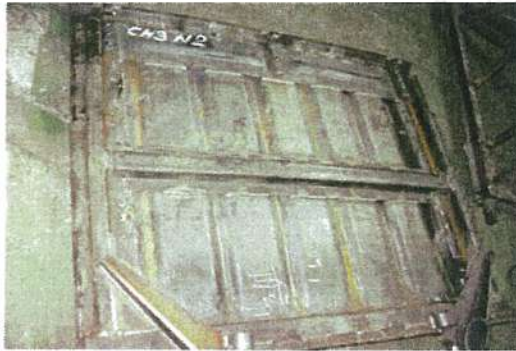
а) до начала испытаний
