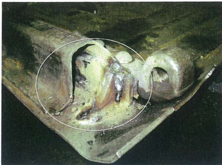
Рис. 12. Испытуемый образец № 1 – после проведения ремонта
